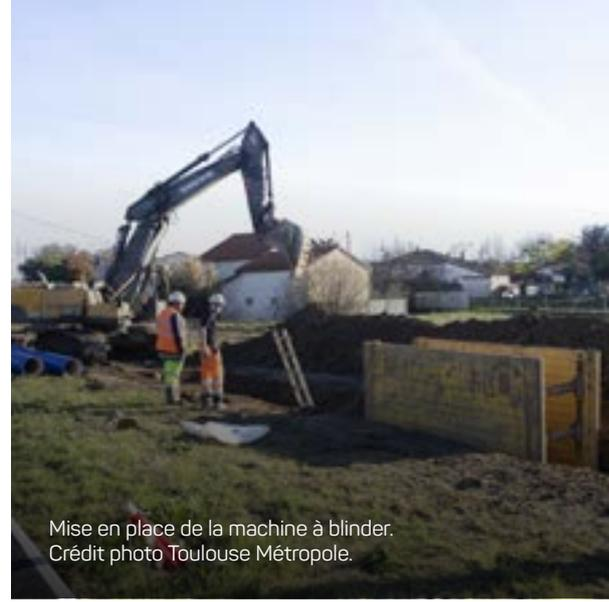
Mise en place de la machine à blinder.
