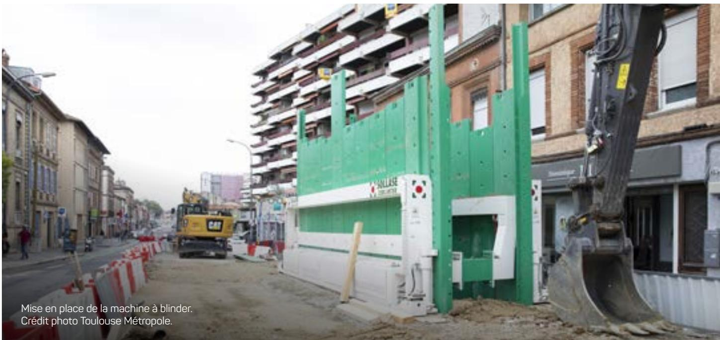
Mise en place de la machine à blinder.
