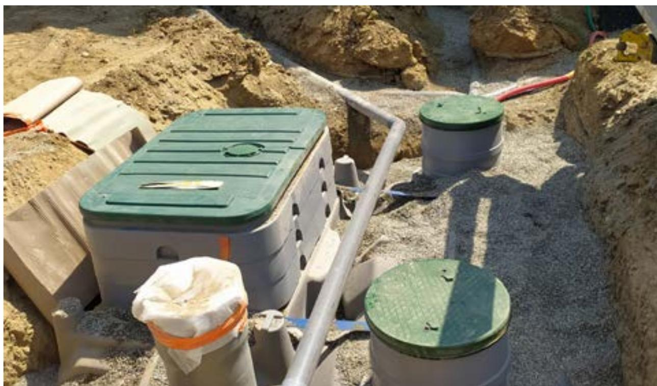
Contrôle d'installation d'assainissement autonome avant remblai. Crédit photo Eau de Toulouse Métropole - service assainissement.
