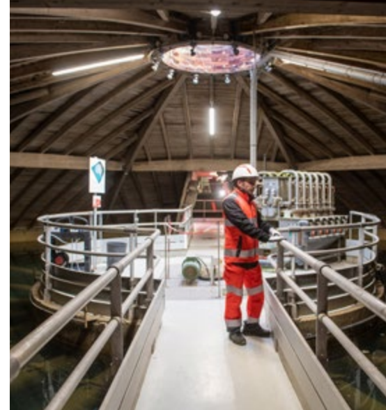
Décanteur de l'usine de Pech-David. Crédit: photo Eau de Toulouse Métropole - service eau potable Guillaume Olivier.
