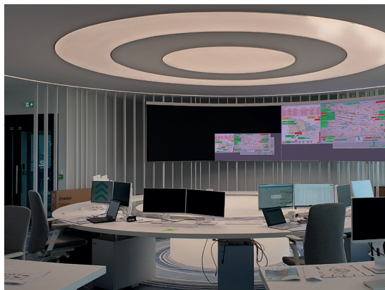
Centre COMET au cœur de l'usine de Pech-David. Crédit photo Eau de Toulouse Métropole - service eau potable.
