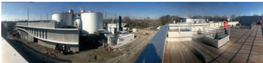
Vue panoramique de l'installation de méthanisation en fin de chantier depuis le belvédère pédagogique
