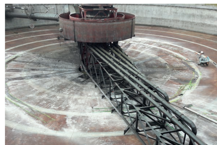
Reprise des fissures du clarificateur G1
