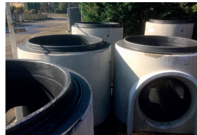
Renforcement d'un réseau structurant rue Gaston Doumergue à Tournefeuille en canalisation grés DN 300 et regards avec traitement époxy
