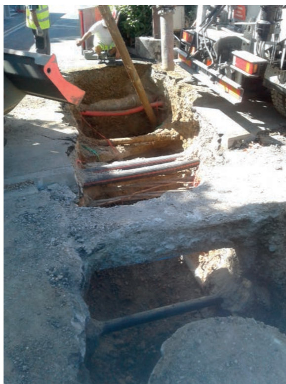
Réhabilitation du réseau en tranchée ouverte rue Bergeron à Saint-Alban (croisement des concessionnaire-terrassement à l'aspiratrice)
